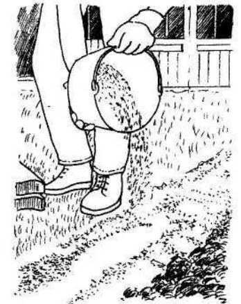
6. На ширину бордюрного камня насыпать цемент, смешать его с песком и увлажнить
