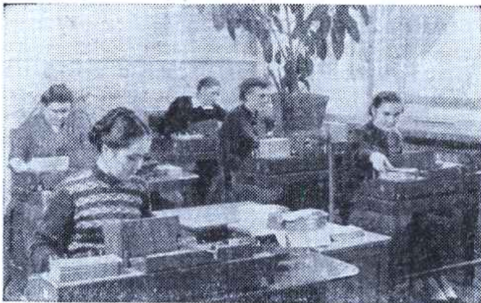
Цех перфорации. Здесь данные переносятся с первичного документа на перфокарту.
